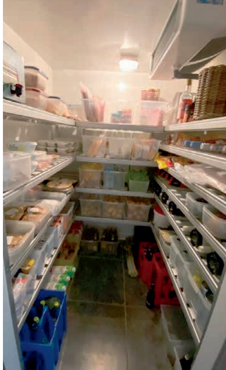
De koelinstallatie bestaat uit een binnentoestel (verdamer) en een buitentoestel (condensing unit)
