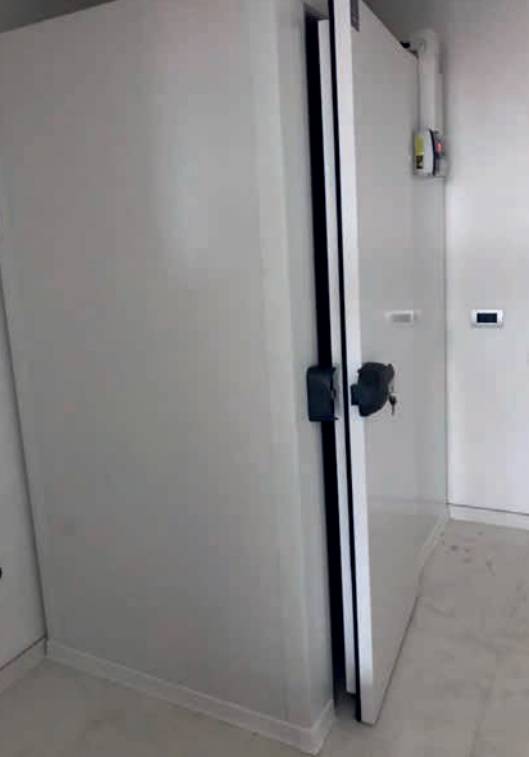
Mooie afmetingen voor een koelcel zijn 1,2 x 1,5 m want dan kan er een u-vormig rek geplaatst worden
